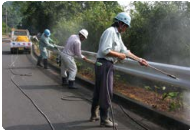
↑青年部によるガードレール清掃
