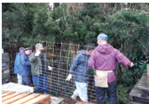
↑ワイヤーメッシュ柵の設置
