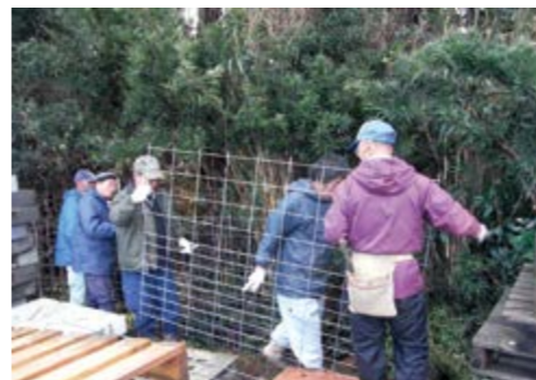
↑ワイヤーメッシュ柵の設置
