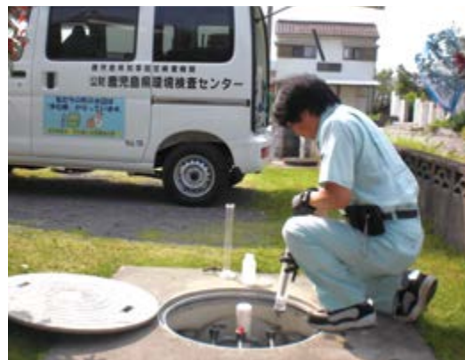
↑ 法定検査を行う検査員
