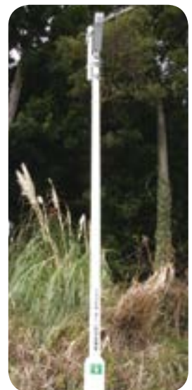
↑山門野地区の県道沿いに設置された防犯灯
