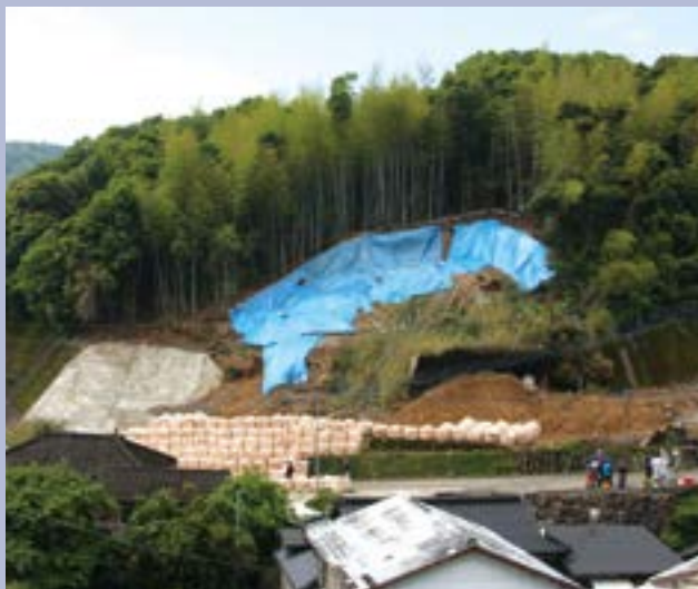
↑ブルーシートで覆われ、大型の土嚢が積み上げられた地すべり発生場所
