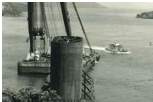
↑建設中の大橋の前を横切る黒之瀬戸丸
