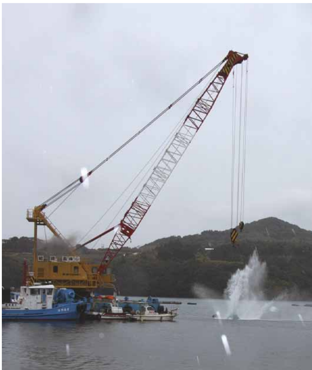
↑合図とともに礎石が投入され海面に水しぶきがあがる
