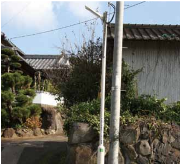
↑上揚集落に設置された防犯灯
