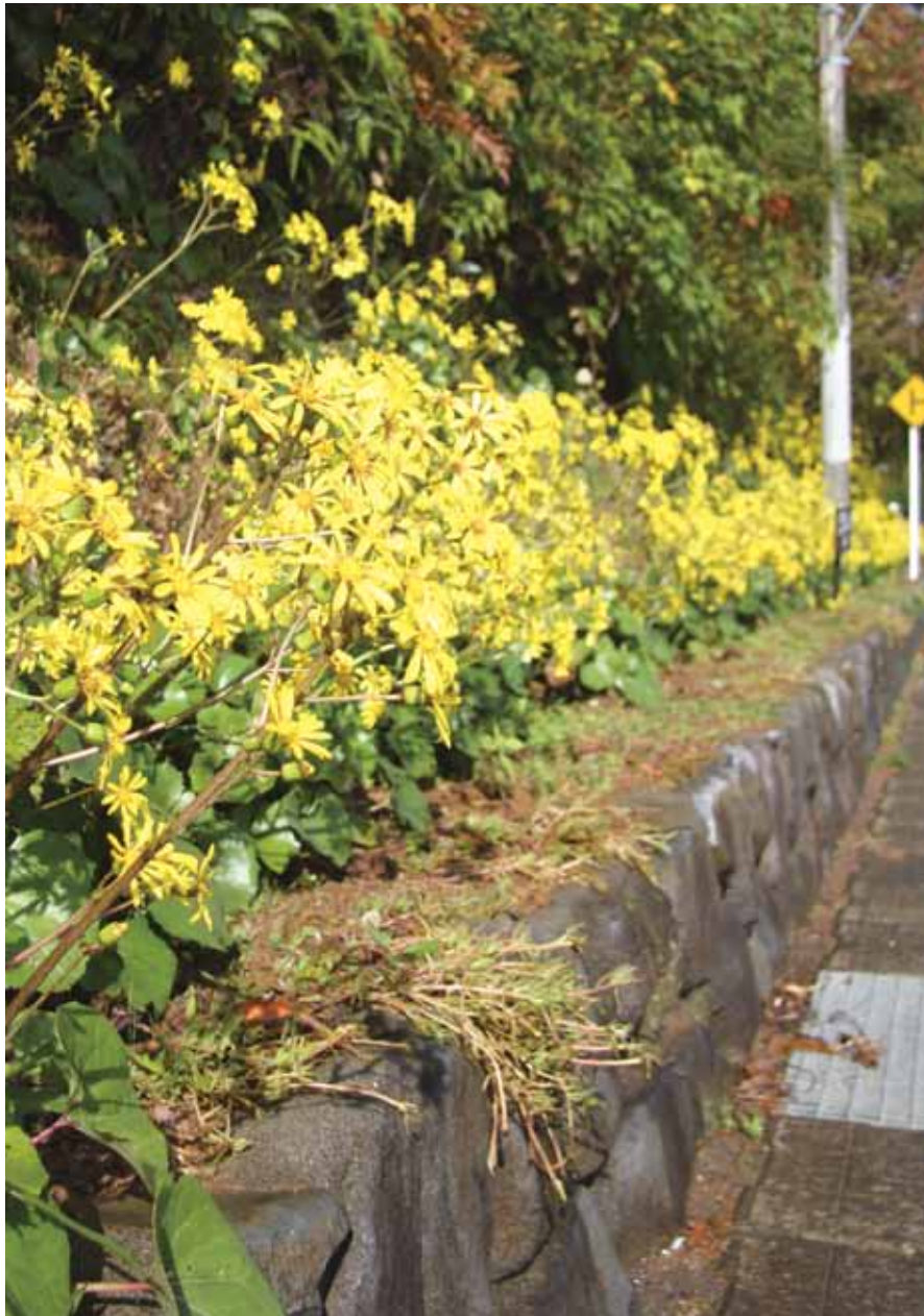
(県道葛輪瀬戸線 塩追入口付近)
