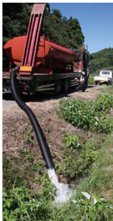
↑大型のタンクから勢いよく水路に放水されました
