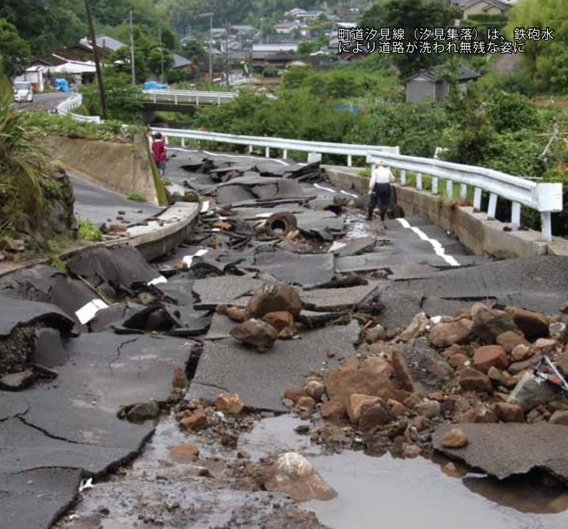
城川内川が氾濫し、護岸は崩れ管理道と水田が被害
