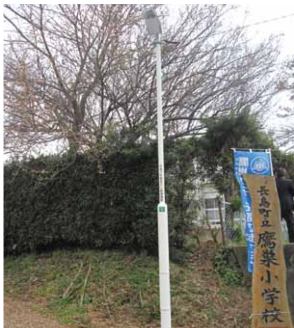
鷹巣小学校下に設置された防犯灯↑
