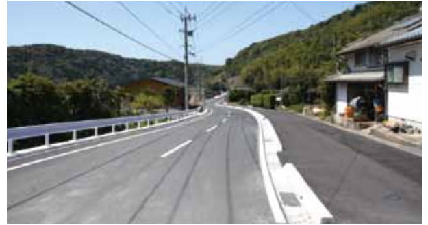
改良が進む町道山門野汐見線（馬込地内）↓
