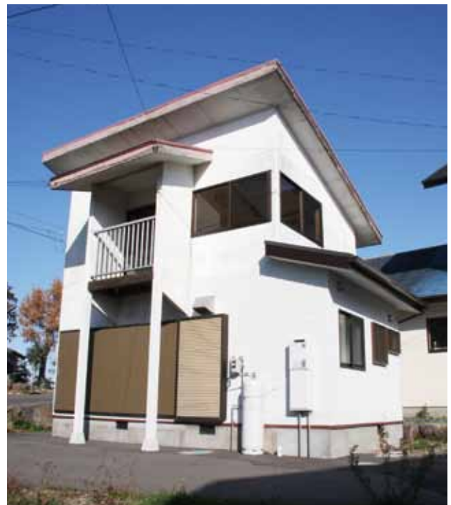
↑ 被災者に提供される「太陽の里」のケビン
