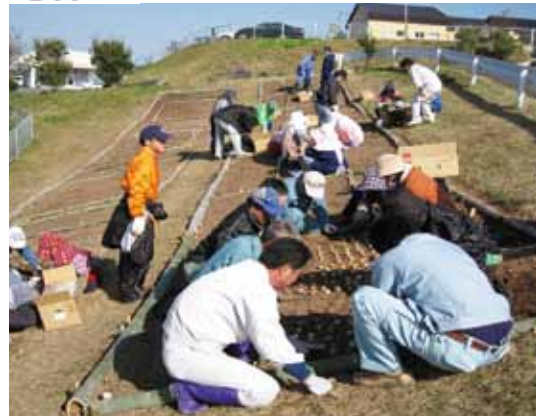
↑サンセット長島の駐車場法面への植栽
