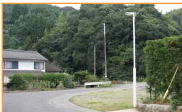
福ノ浦に設置された防犯灯 ↑
