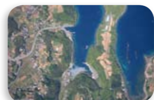
←蔵之元漁港を整備
