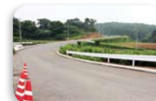
←町道鷹巣杉ノ段線を舗装
