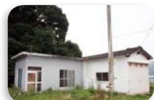
←福ノ浦と湯ノ口の消防格納庫を新築
