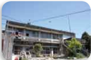
← 老朽化した旧東町役場の庁舎を解体
