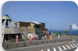
← ポテトハウス望洋の売店を増築
