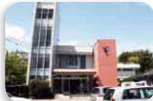
← 鷹巣診療所の屋根を防水工事
