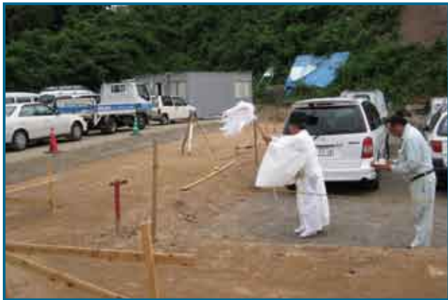
↑安全な施工を願う起工式
