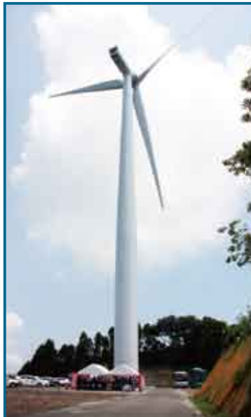
↑馬込に建設された風力発電施設
