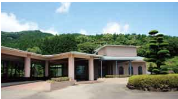
↑火葬場「不知火苑」のエアコンを改修
