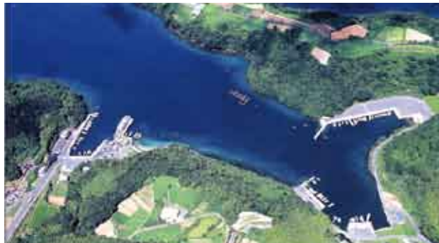
↑ 防波堤、護岸、道路等が整備される蔵之元漁港
