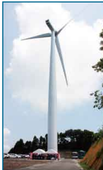
↑馬込に建設された風力発電施設
