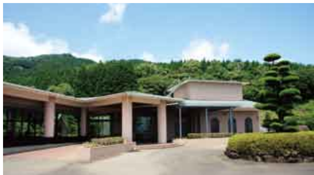
↑ 火葬場「不知火苑」のエアコンを改修
