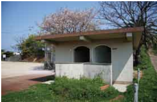
→城川内運動場のトイレを改修
