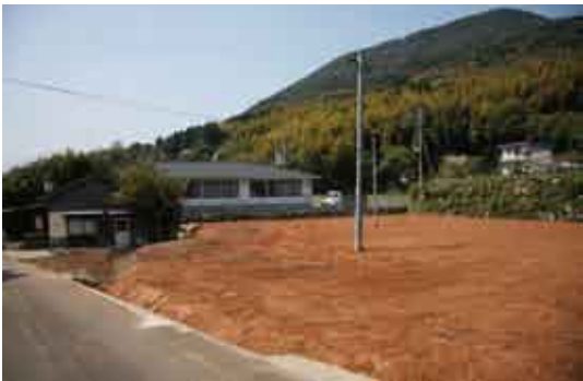
→川床診療所横に公営住宅を新築
