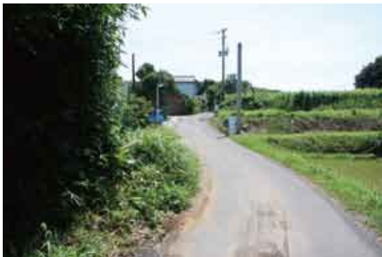
延長 220 m、幅 4 m 改良される山中の農業集落道
