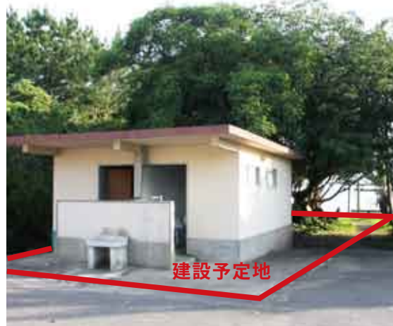
小浜海水浴場に管理人室、トイレ、シャワー室、監視人室等を備えた施設を整備
