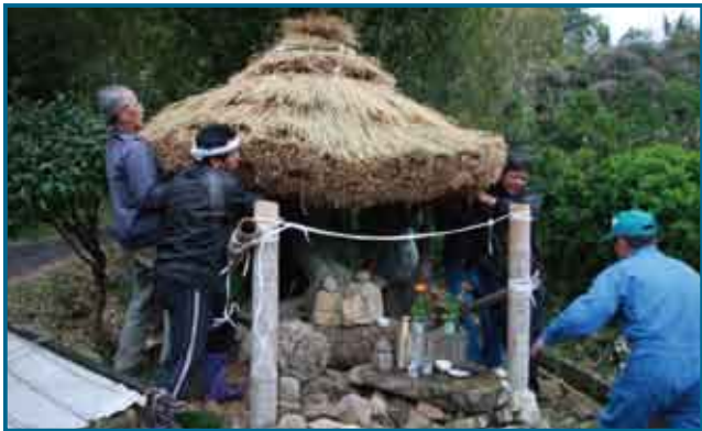
↑釘などを使わずにわら葺屋根を造り替え
