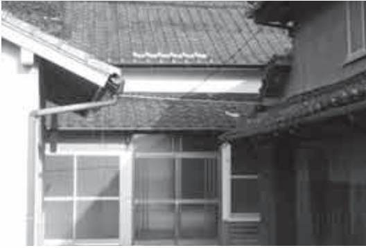
↑ 定住促進のために改修される空家（福ノ浦）
