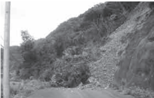
↑ 通行止めになっている獅子島一周林道
