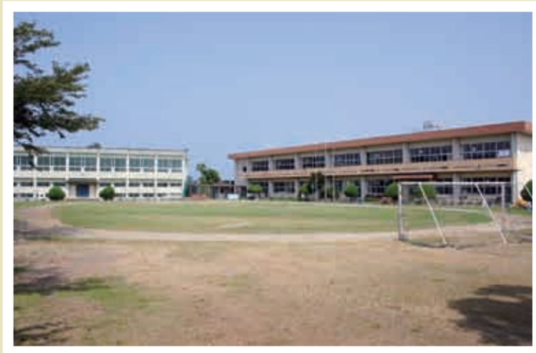
↓照明施設が整備される本浦小の屋外運動場
