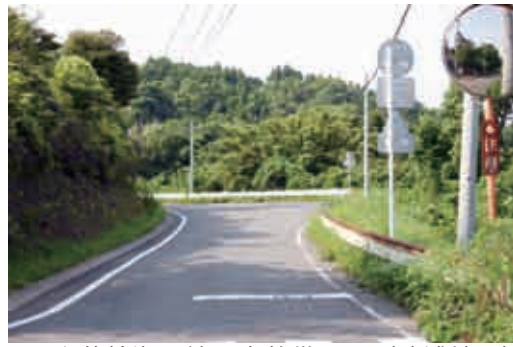
↑葛輪瀬戸線の未整備区間（諸浦地区）
