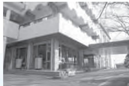
①長島町開発総合センター ホール・会議室・図書館など
