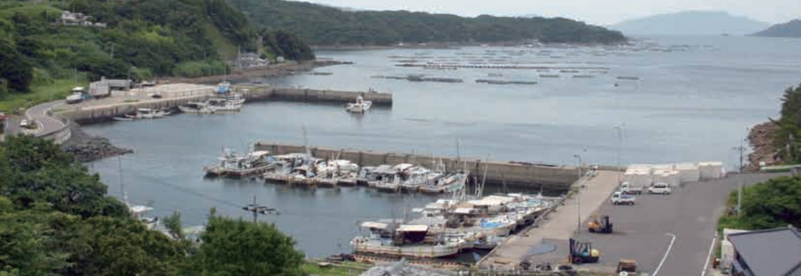
↑着々と整備が進められる本浦の港
