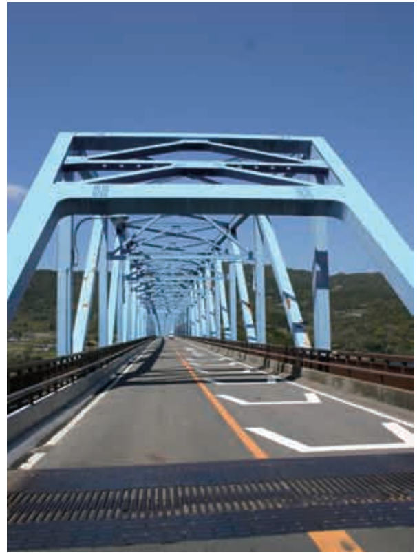
→補修される黒之瀬戸大橋
