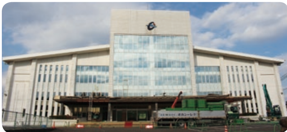
↑改修工事が始まった総合町民体育館
