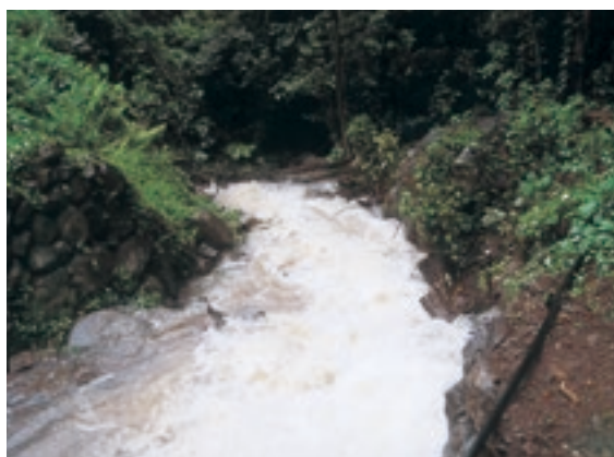
↑未改良地区の田尻川
