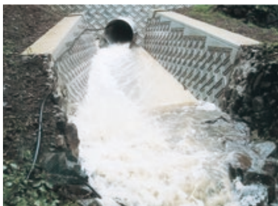
↑国道389号線の改良された暗渠
