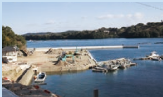
↑改修が進む口之福浦地区
