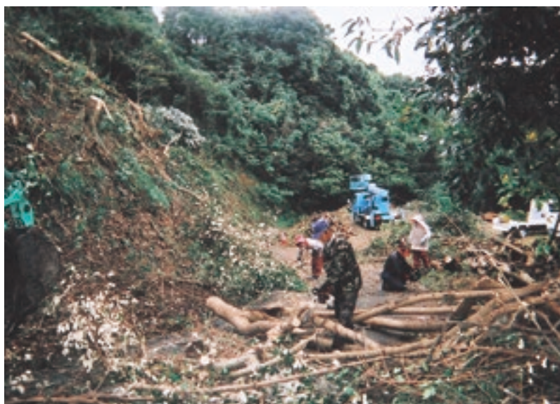
↑林道の支障木伐採状況
