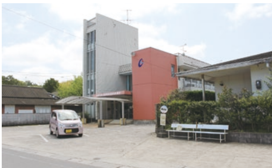
↑ 築後36年経過した鷹巣診療所
