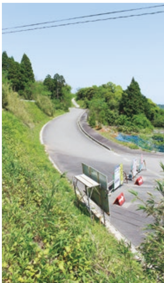
↑改良が進む県道葛輪瀬戸線（本浦入り口付近）
