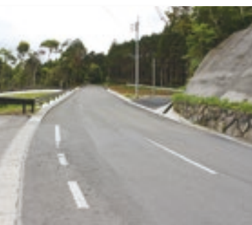
整備が進む 町道藤之元口之福浦線
