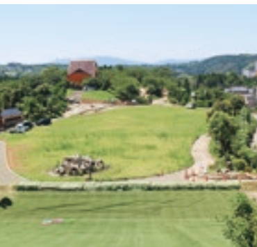
改修されるピクニック広場
