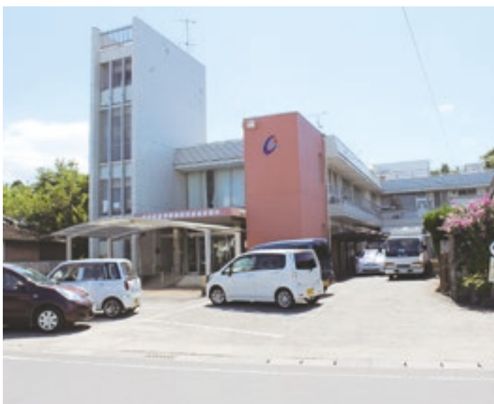
築後35年経過した鷹巣診療所
