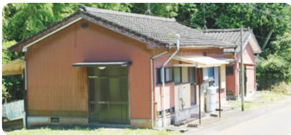
用途廃止となった諸浦地区の一般教職員住宅（手前）
