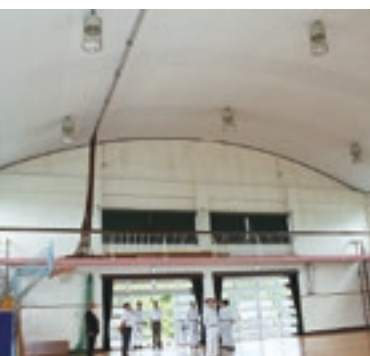
吊り天井の鷹巣小学校体育館
