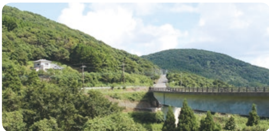
川床地区給水区域となる汐見の一部
