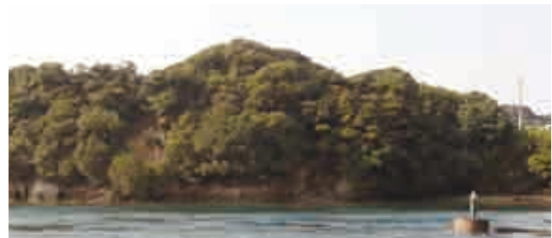
↑崖崩れや浸食被害が見られる乳の瀬戸の諸浦側
