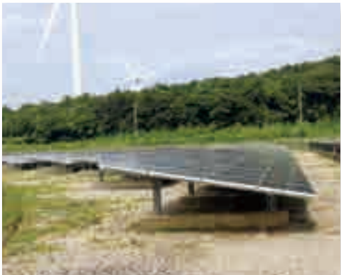
太陽光発電施設の建設 敷地造成、既存送電線の変更工事等 ※写真はイメージ 1億3443万円
