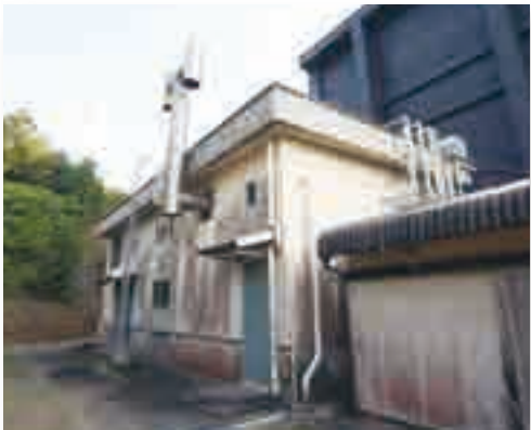
文化ホールの空調施設更新 28年経過した空調施設の更新工事 8532万円
