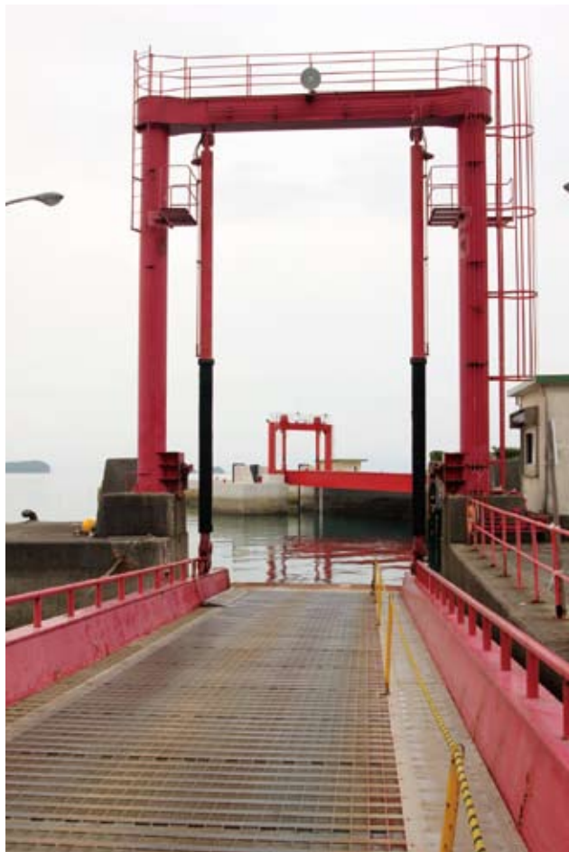
←船舶からの乗降に利用される諸浦港の可動橋（奥は新設の可動橋）
