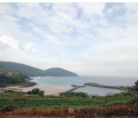
↑ 汐見漁港の堆砂の影響を調査
