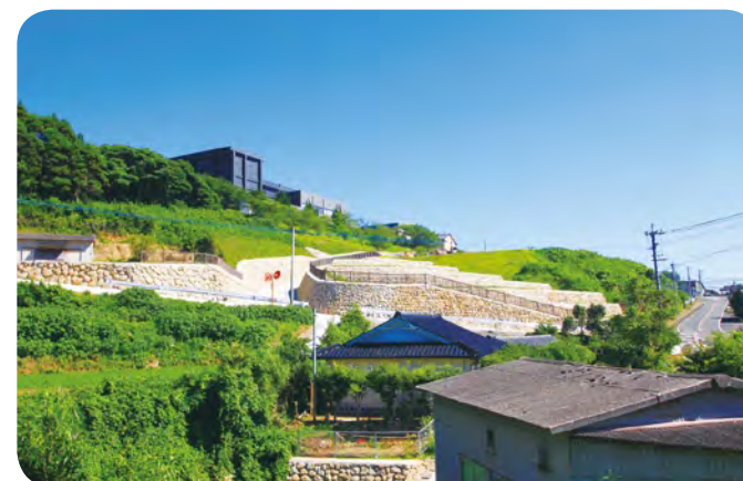
H25へ繰り越されたサンセットストーンパークの取付道路整備
