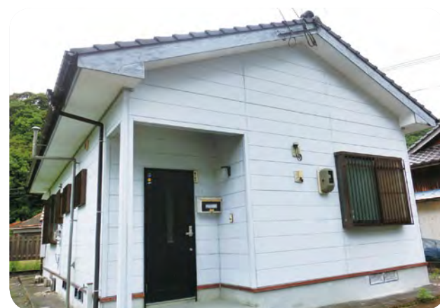
町営住宅として活用される獅子島の教職員住宅
