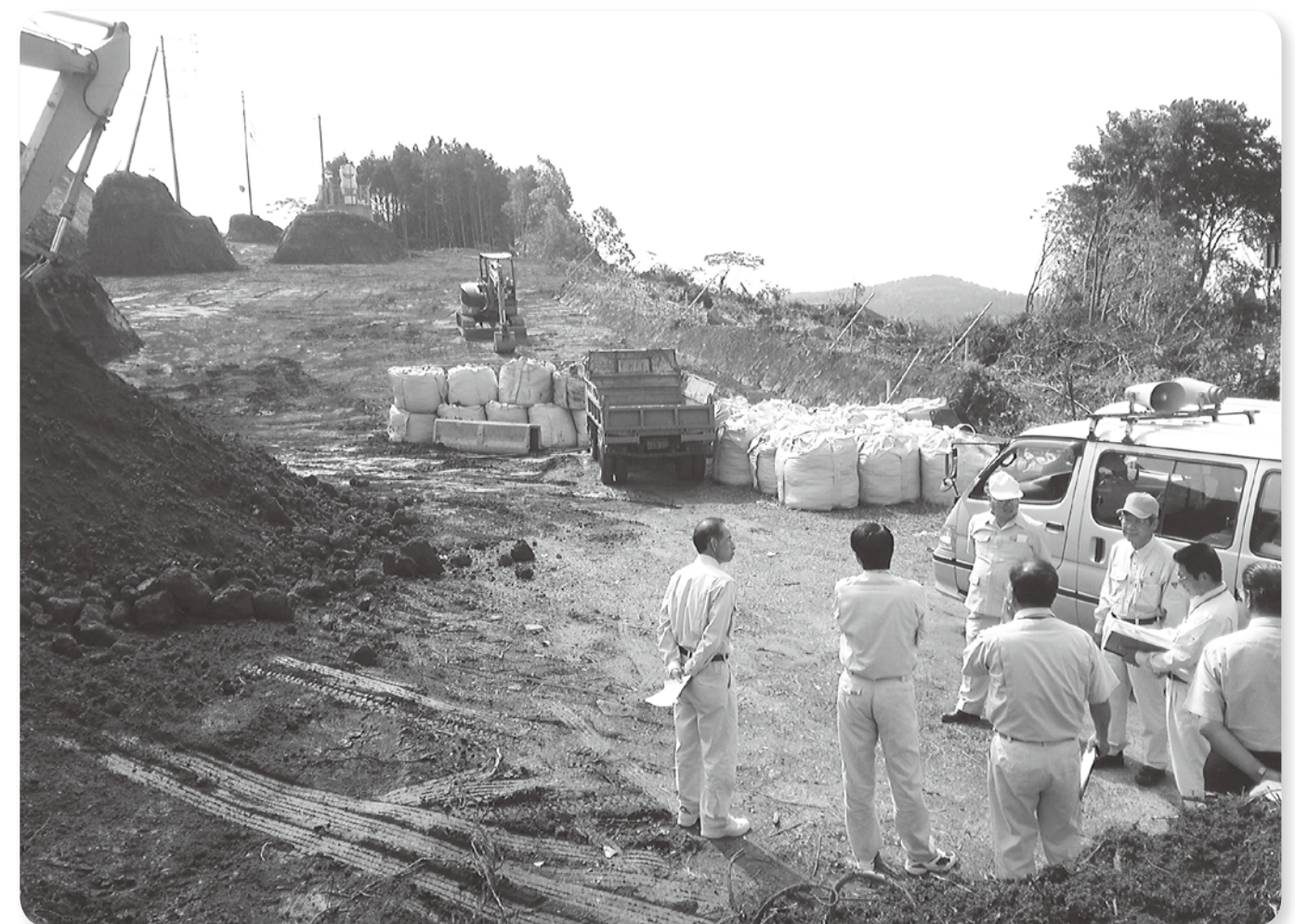
補正予算が計上された町道行人岳線の工事現場を調査する建設経済文教常任委員会
